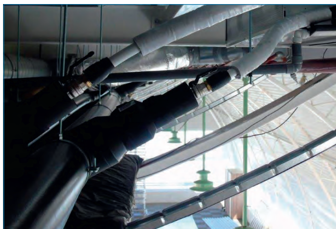
COOL-FIT 2.0 voor koeling in kas Bleiswijk (in aanbouw)
